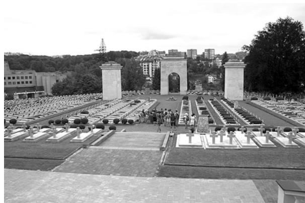
Pylony bez kolumnady
