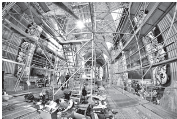
Ostatni poziom rusztowań w nawie głównej, po bokach zawieszono 2 obrazy wielkoformatowe
